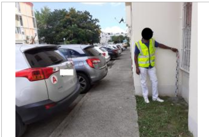
Renforcement bâtiment côté rue
