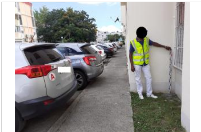
Renforcement bâtiment côté rue
