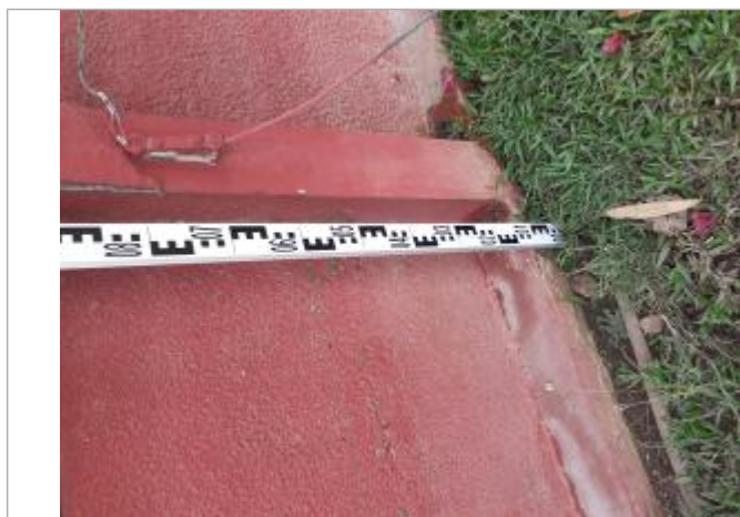
Dépôts de matières solides
