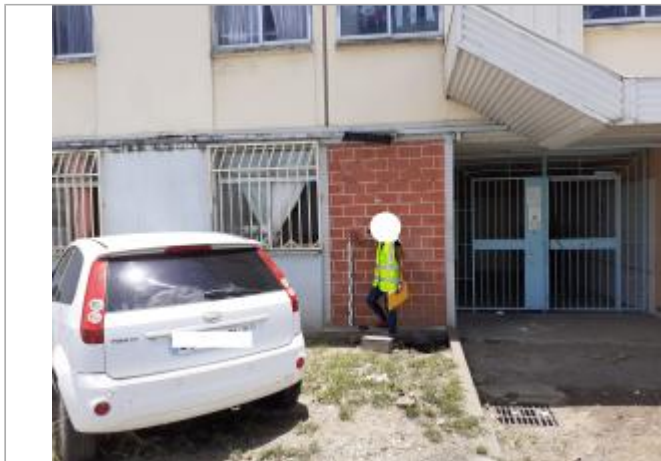
Mur façon brique façade extérieure
