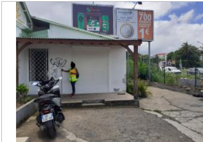
Façade extérieure du bâtiment
