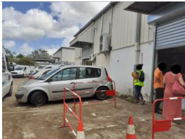
Entrée entrepot mur façade côté parking
