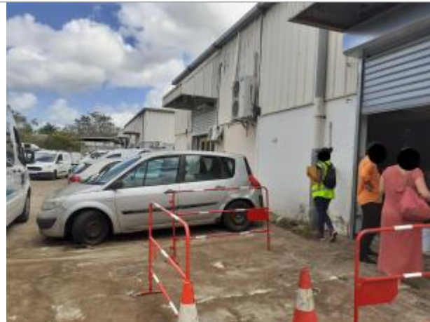
Entrée entrepot mur façade côté parking
