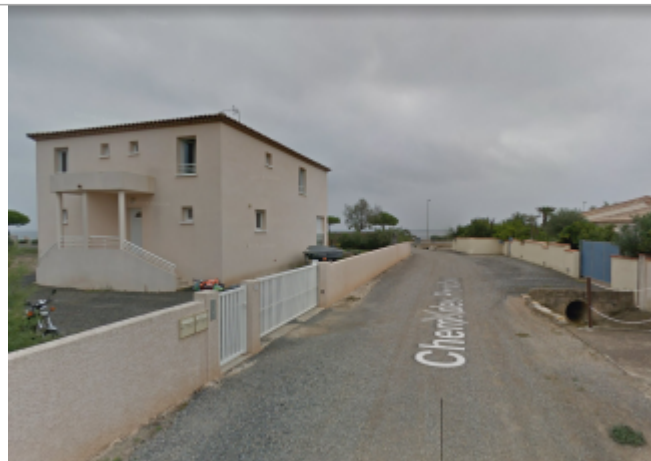
Partie basse du chemin qui donne sur la promenade
