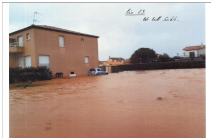
Vue de la maison au n°2
