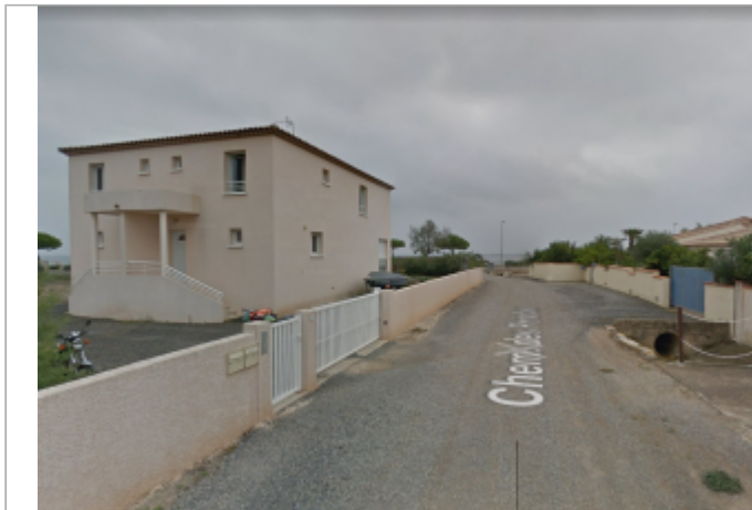
Partie basse du chemin qui donne sur la promenade
