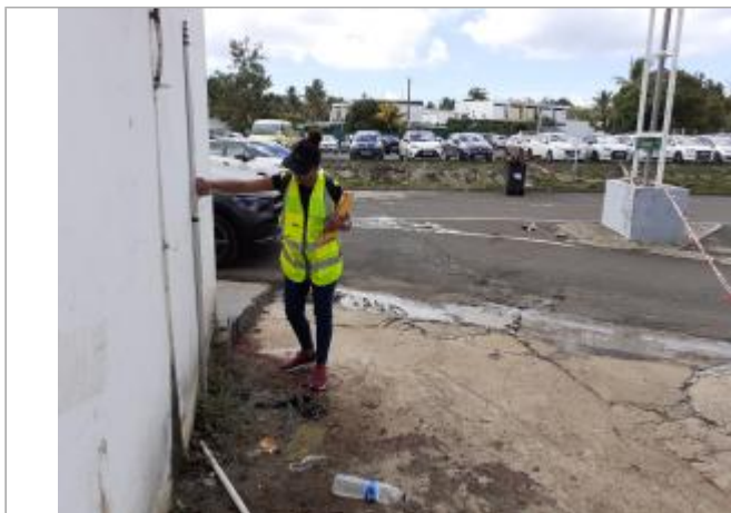
Mur blanc façade extérieure
