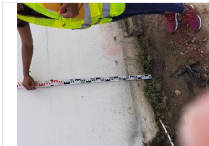
Dépôts de matières solides
