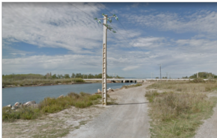
Quai en rive est
