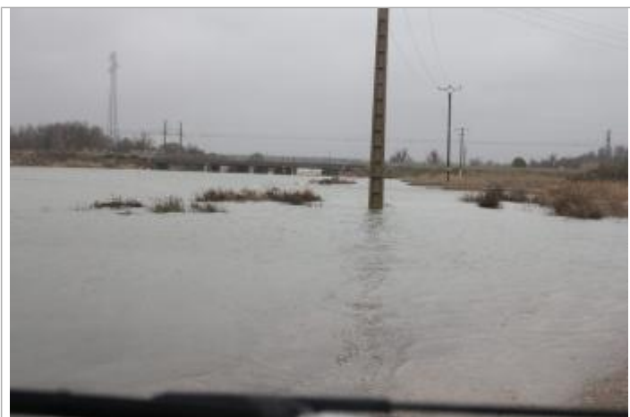
Quai en rive est
