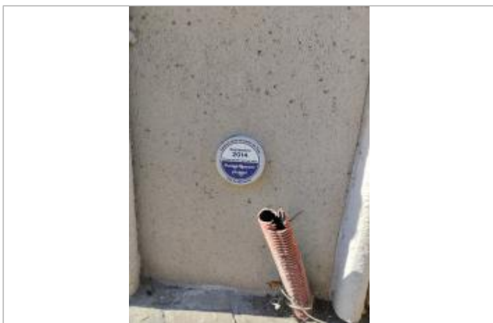
Repère de crue sur la façade de l'opticien
