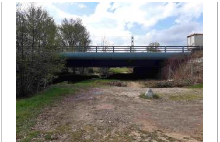
Vue d'ensemble du pont (face amont)
