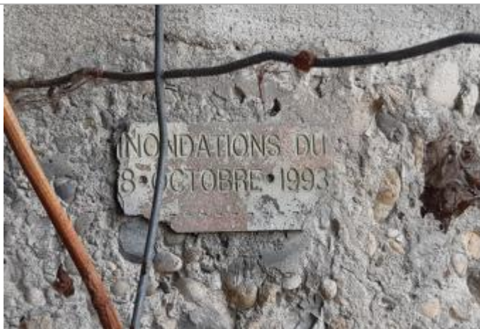
Vue du repère (plaque métallique abîmée)
