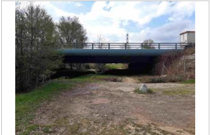
Vue d'ensemble du pont (face amont)
