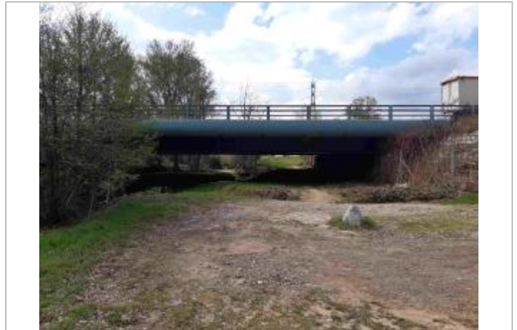
Vue d'ensemble du pont (face amont)
