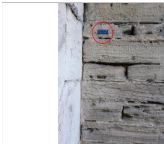
Vue rapprochée du repère (plaque bleue) posé sur la culée rive droite
