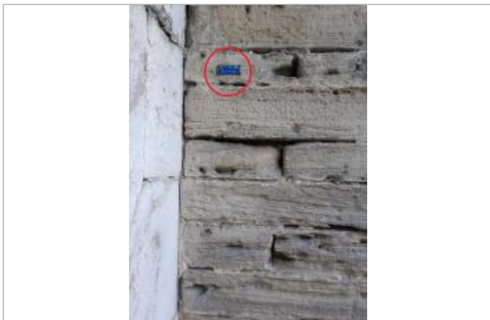
Vue rapprochée du repère (plaque bleue) posé sur la culée rive droite
