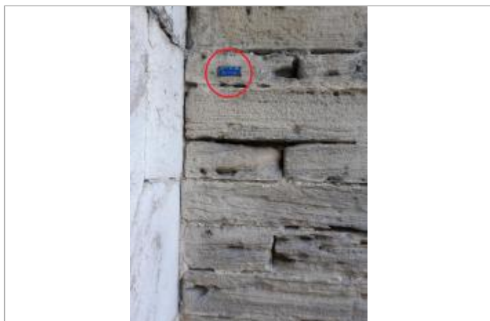
Vue rapprochée du repère (plaque bleue) posé sur la culée rive droite
