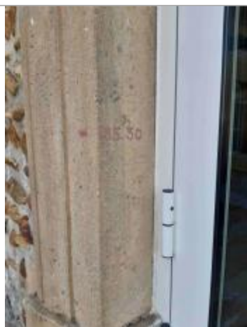
Marque à la peinture indiquant la cote de 165.30 sur le montant de la porte, coté gauche, face au bâtiment.
