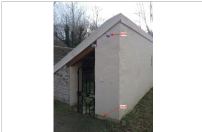
Vue site - Auteur : SPC SMYL
