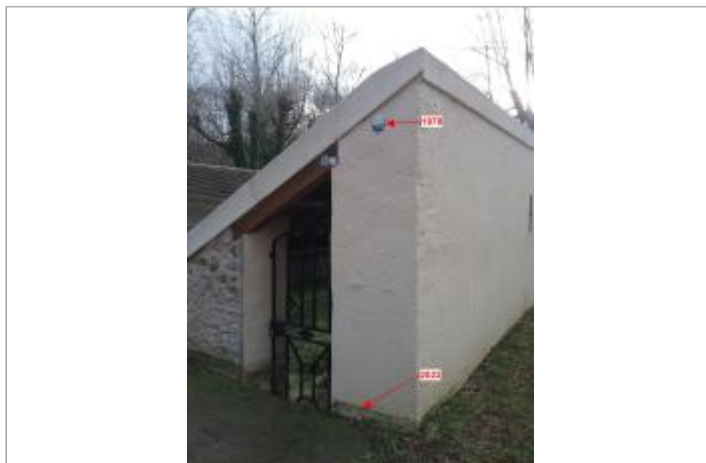
Vue site - Auteur : SPC SMYL
