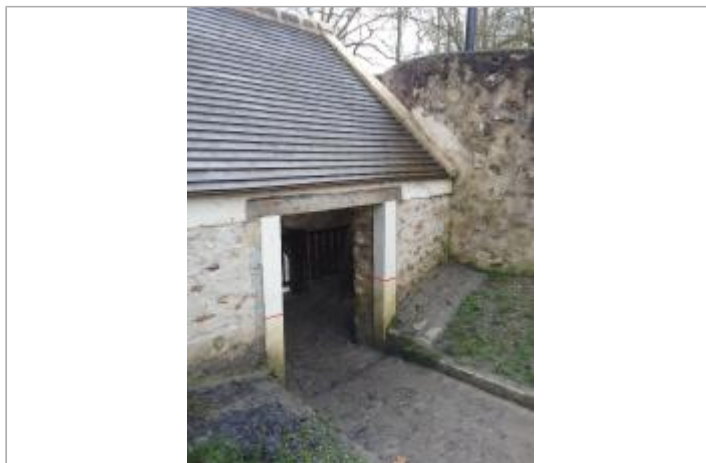
Vue site - Auteur : SPC SMYL
