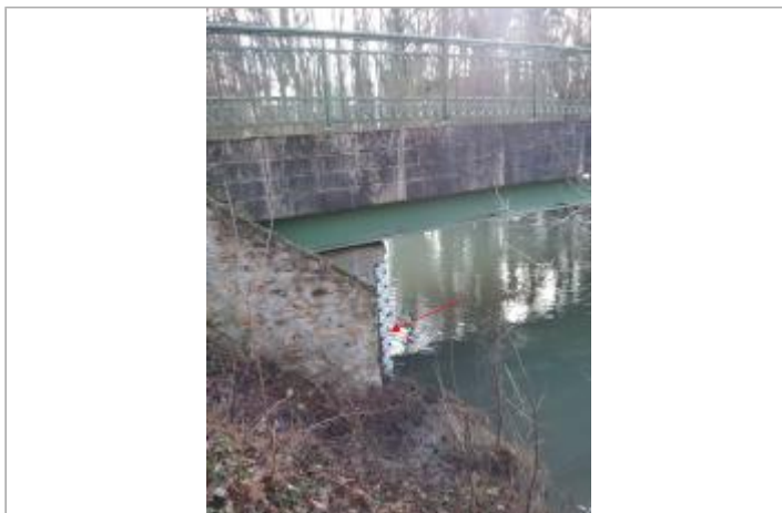
Vue site - Auteur : SPC SMYL
