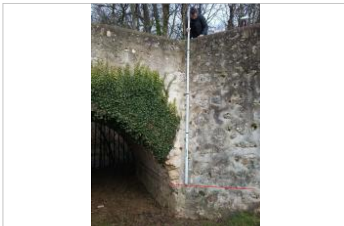
Vue site - Auteur : SPC SMYL
