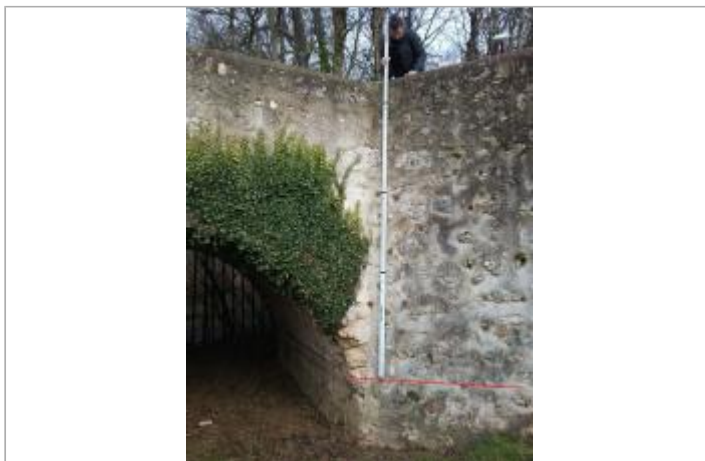
Vue site - Auteur : SPC SMYL
