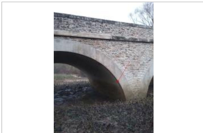
Vue site - Auteur : SPC SMYL
