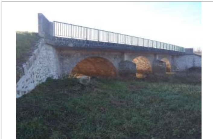
Vue site - Auteur : SPC SMYL
