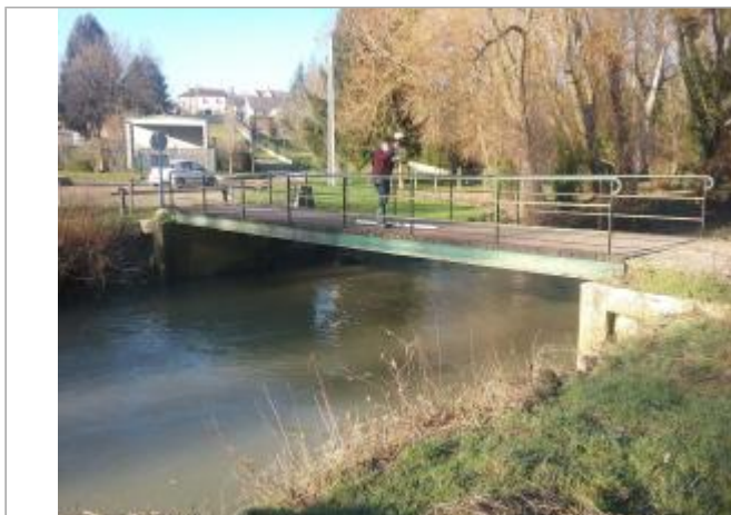
Vue site - Auteur : SPC SMYL
