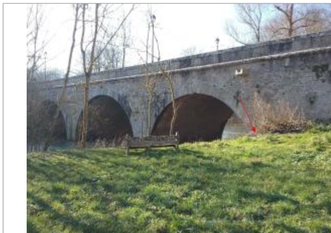
Vue site - Auteur : SPC SMYL
