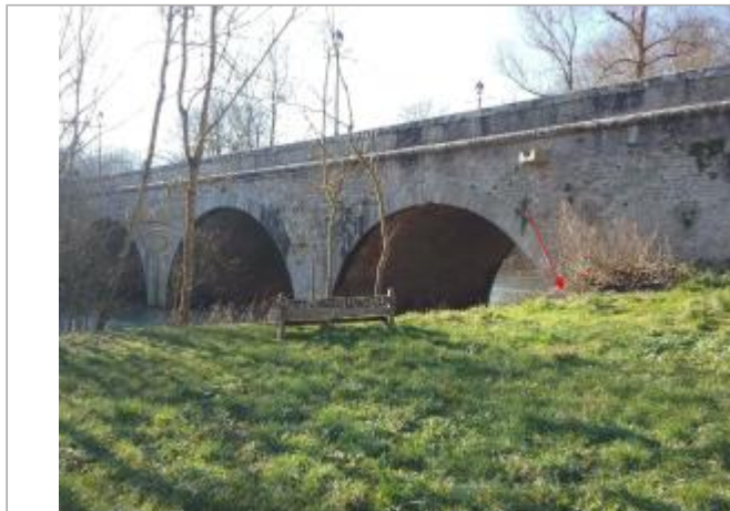
Vue site - Auteur : SPC SMYL
