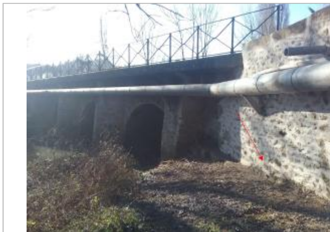
Vue site - Auteur : SPC SMYL
