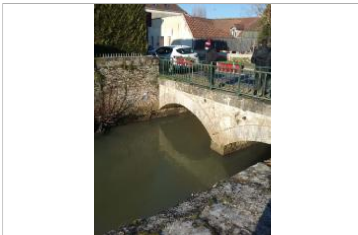
Vue site - Auteur : SPC SMYL
