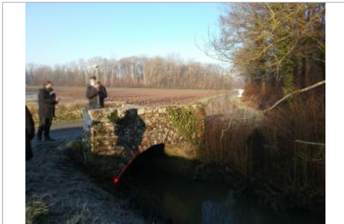
Vue site - Auteur : SPC SMYL
