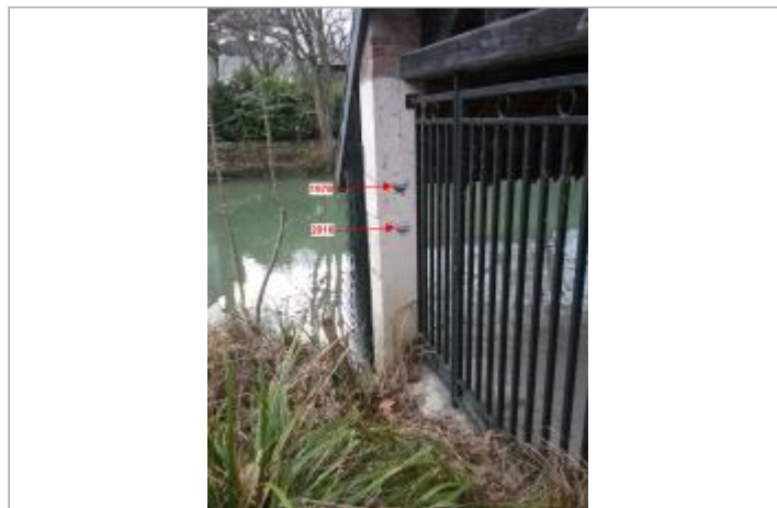
Vue site - Auteur : SPC SMYL
