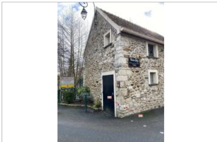
Vue site - Auteur : SPC SMYL
