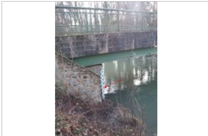
Vue site - Auteur : SPC SMYL
