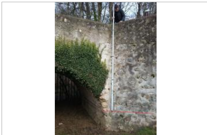
Vue site - Auteur : SPC SMYL
