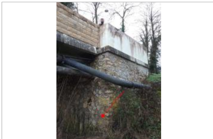
Vue site - Auteur : SPC SMYL
