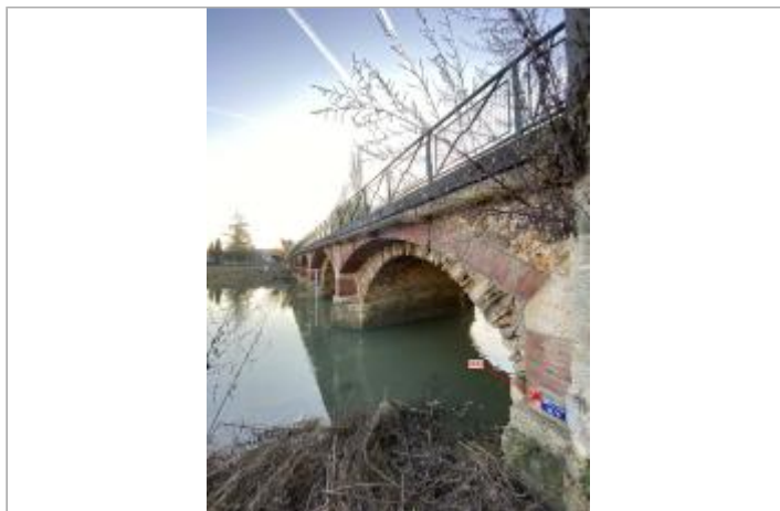
Vue site - Auteur : SPC SMYL
