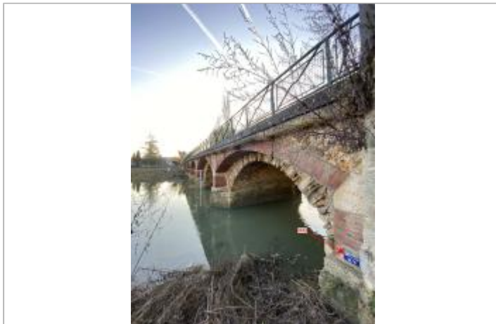
Vue site - Auteur : SPC SMYL
