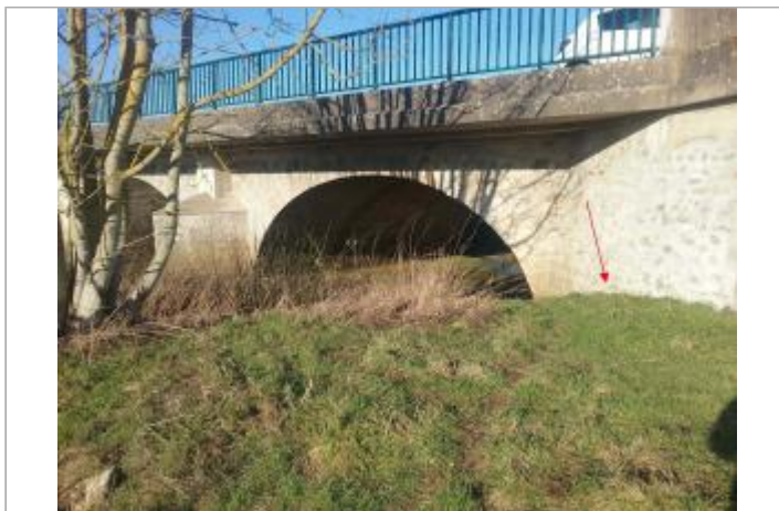
Vue site - Auteur : SPC SMYL
