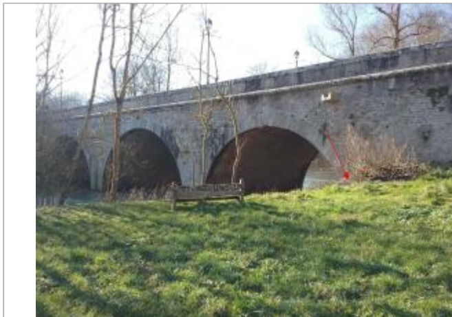
Vue site - Auteur : SPC SMYL
