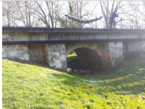
Vue site - Auteur : SPC SMYL
