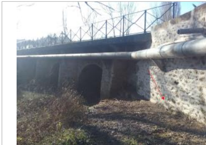
Vue site - Auteur : SPC SMYL
