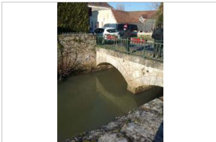
Vue site - Auteur : SPC SMYL
