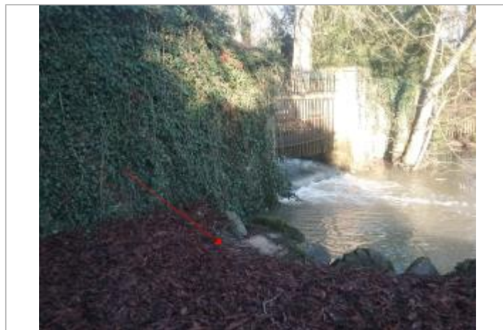
Vue site - Auteur : SPC SMYL
