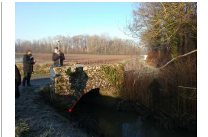
Vue site - Auteur : SPC SMYL
