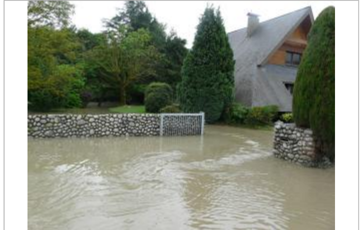
Débordement du Gabarret à Lau-Balagnas
