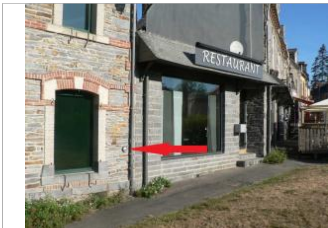
Bâtiment au 8 place de la ferronnerie à La Gacilly
