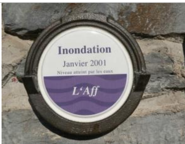
Repère normalisé de l'inondation du 5 janvier 2001
