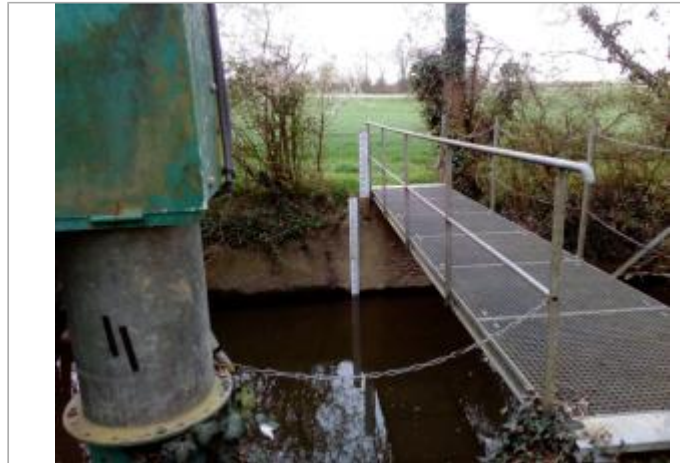
Station limnimétrique de l'Aron à Grand-Fougeray
