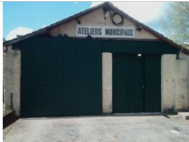
Vue du site - auteur : Artelia
