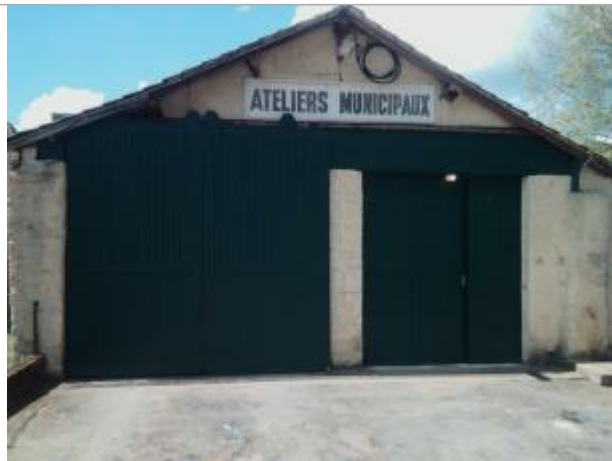
Vue du site - auteur : Artelia
