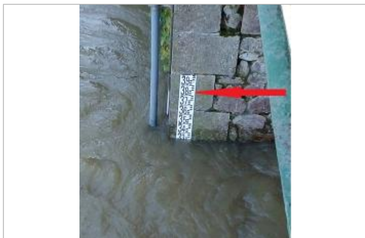
Echelle limnimétrique du Semnon à Bain de Bretagne lors de la crue de décembre 2020
