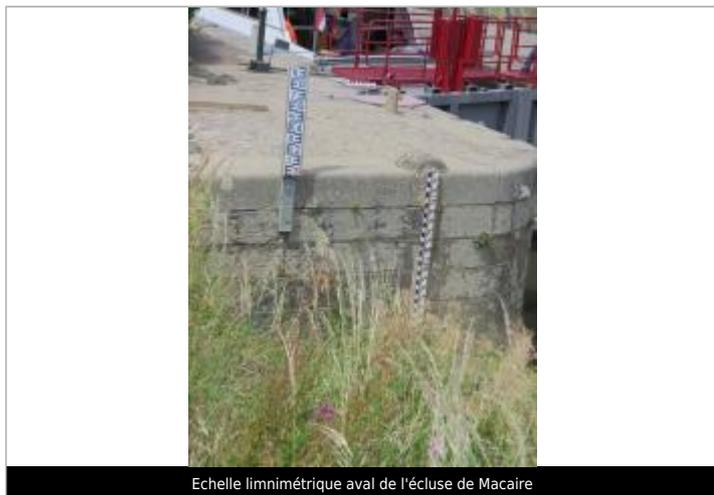
Echelle limnimétrique aval de l'écluse de Macaire
