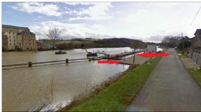
Amont écluse de Macaire à Saint-Malo-de-Phily en 2009
