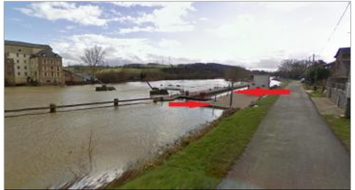
Amont écluse de Macaire à Saint-Malo-de-Phily en 2009
