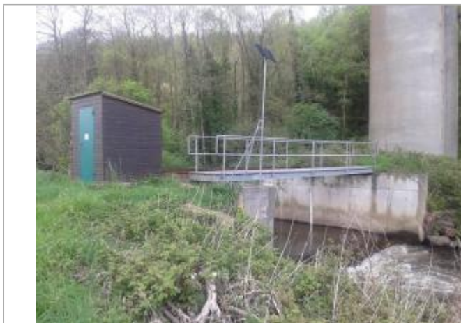
Station limnimétrique de l'Aven sous la RN 165
